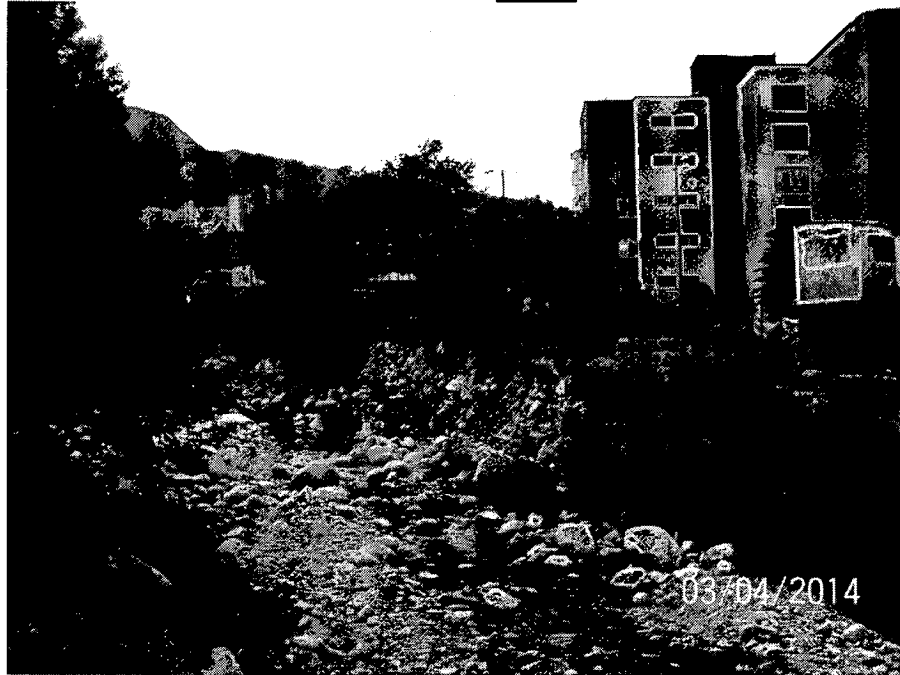
Imagen No.4 Socavamiento, margen izquierdo del Río Fucha, en el área de la Unidad Residencial San Cristóbal, Localidad San Cristóbal Sur. Aguas arriba del puente vehicular de la carrera 3, Localidad de San Cristóbal Sur.
