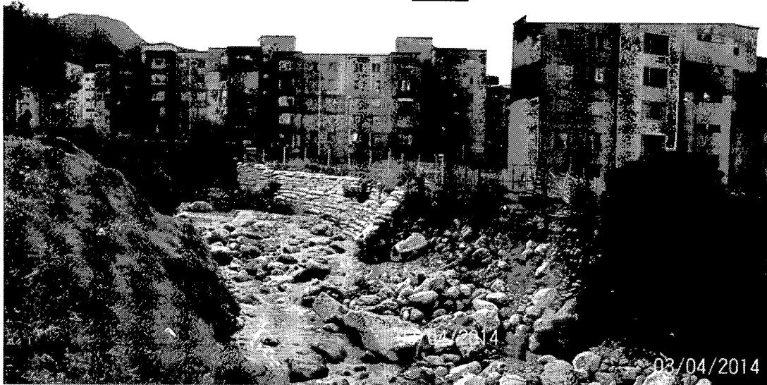
Imagen No.2 Se aprecia la socavación que sufrió el talud en el área de la Unidad Residencial San Cristóbal, Localidad San Cristóbal Sur. Aguas arriba del puente vehicular de la carrera 3, margen izquierdo, Localidad de San Cristóbal Sur.
